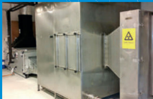
Instalacja Centriair o wydajności 5.000 m 3 /h z reaktorem UV, filtrem z węglem aktywnym
