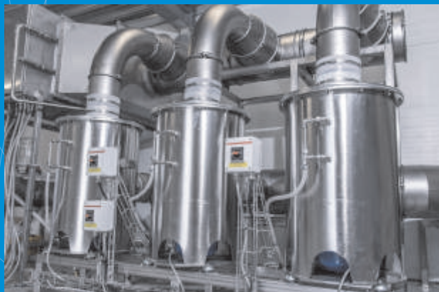
Instalacja oczyszczania powietrza o wydajności 6 000 m 3 /h system CentrOx z reaktorem UV oraz wentylatorem z instalacją wywiewną
